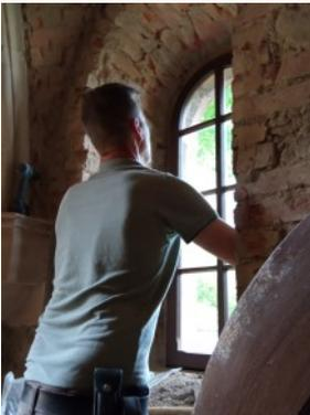
Weiterhin haben die Arbeiten in den Turmkammern begonnen. So wurden die Laibungen der drei- und vierbogigen Fenster ausgemauert und das lose Mauerwerk wieder mit Porphyrsteinen aufgebaut.
